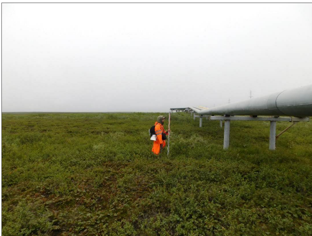
Рис. 38 – Фото. НАО, Заполярный район. Западно-Хоседаюское месторождение. ТФ № 16. Вид на подболоченную тундру на участке обследования трассы наземного трубопровода. Снято с юго-запада
