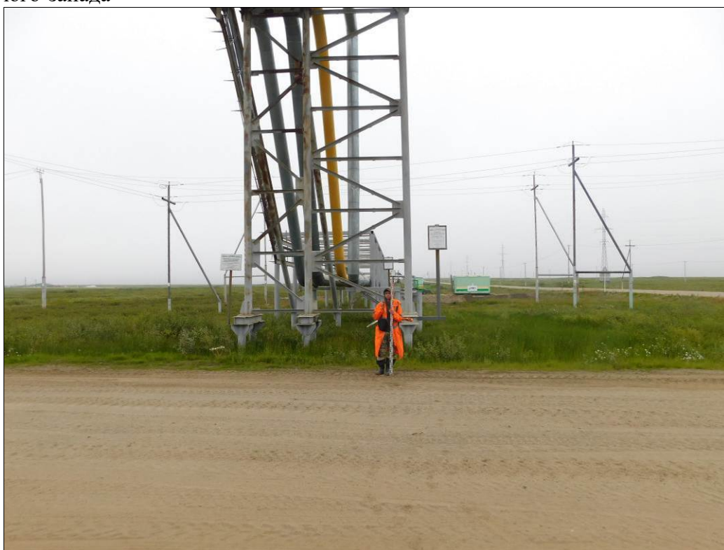
Рис. 43 – Фото. НАО, Заполярный район. Западно-Хоседаюское месторождение. ТФ № 20. Участок натурального обследования. Окончание трассы наземного трубопровода. Снято с юго-запада
