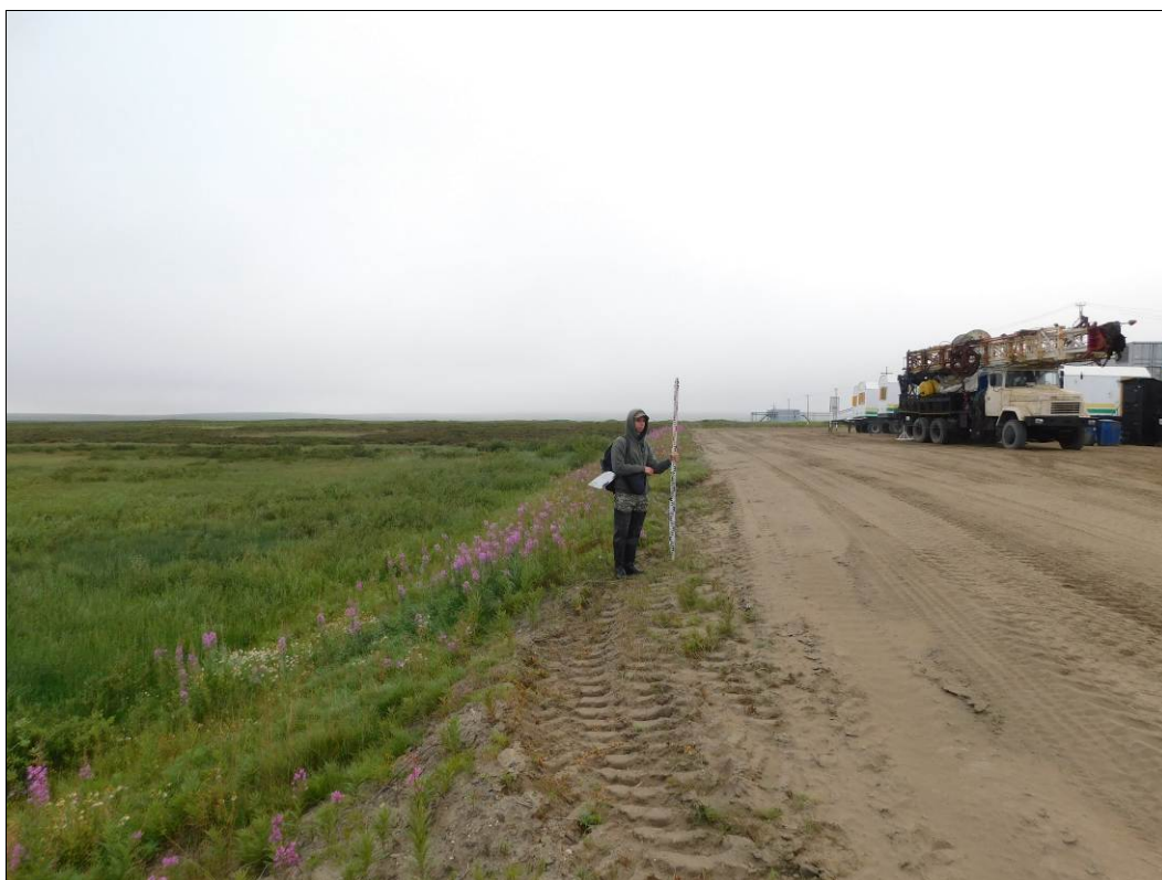
Рис. 55 – Фото. НАО, Заполярный район. Западно-Хоседаюское месторождение. ТФ № 26. Вид на участок обследования южной части кустовой площадки № 8-бис. Снято с востока
