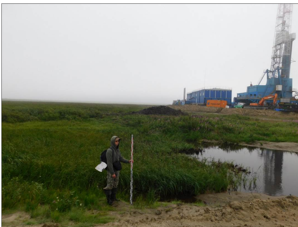
Рис. 45 – Фото. НАО, Заполярный район. Западно-Хоседаюское месторождение. ТФ № 22. Вид на участок обследования северной части кустовой площадки № 8-бис. Снято с запада
