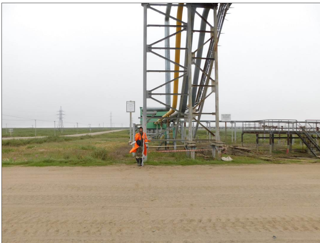
Рис. 44 – Фото. НАО, Заполярный район. Западно-Хоседаюское месторождение. ТФ № 20. Участок натурного обследования. Окончание трассы наземного трубопровода. Снято с северо-востока
