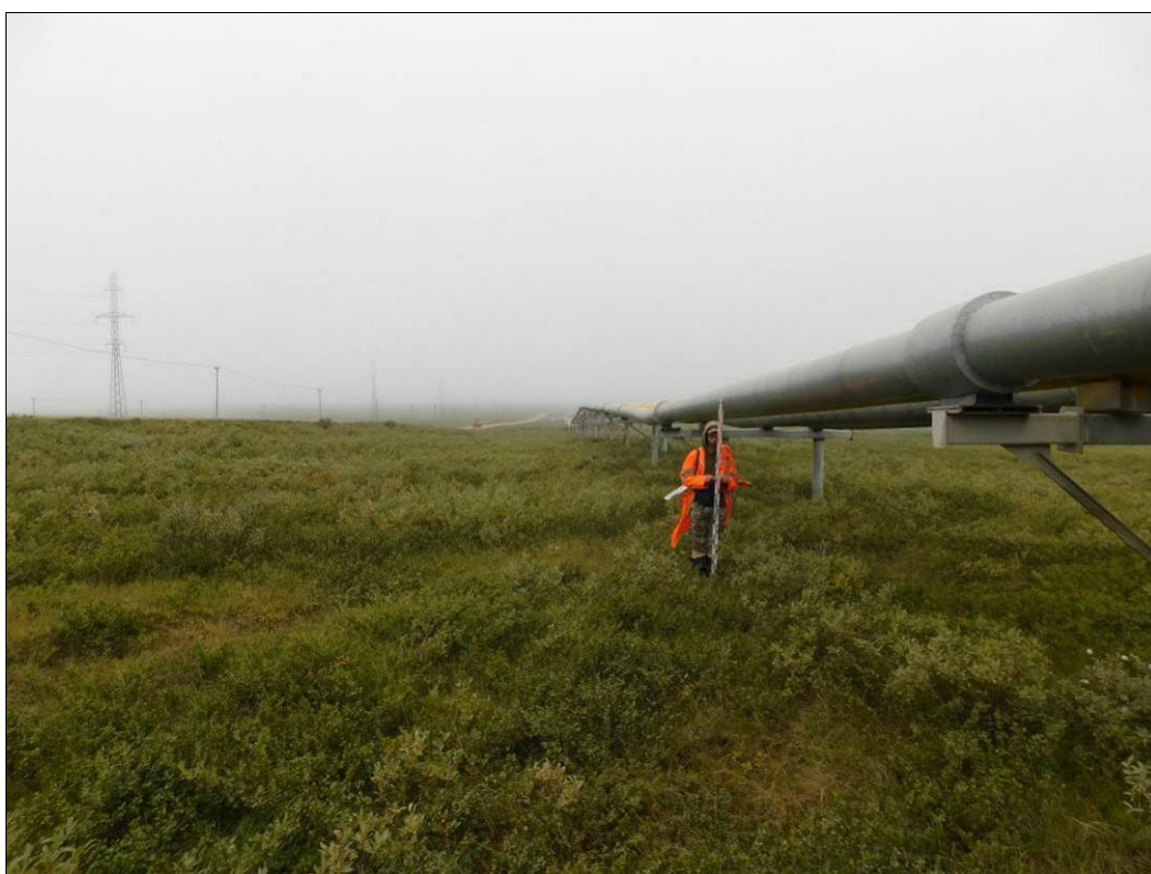
Рис. 41 – Фото. НАО, Заполярный район. Западно-Хоседаюское месторождение. ТФ №19. Вид на заболоченную тундру на участке обследования трассы наземного трубопровода. Снято с северо-востока
