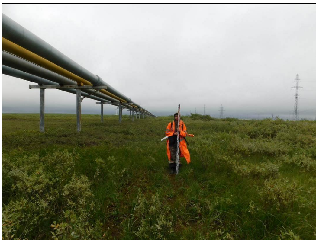
Рис. 33 – Фото. НАО, Заполярный район. Западно-Хоседаюское месторождение. ТФ № 12. Вид на участок прокладки наземного трубопровода. Снято с юго-запада
