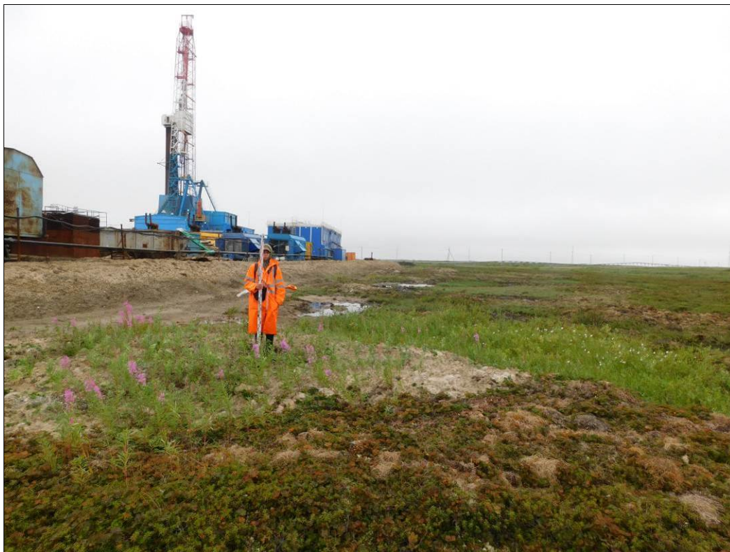
Рис. 64 – Фото. НАО, Заполярный район. Западно-Хоседаюское месторождение. ТФ № 31. Вид на участок обследования северной части кустовой площадки № 8-бис. Снято с востока
