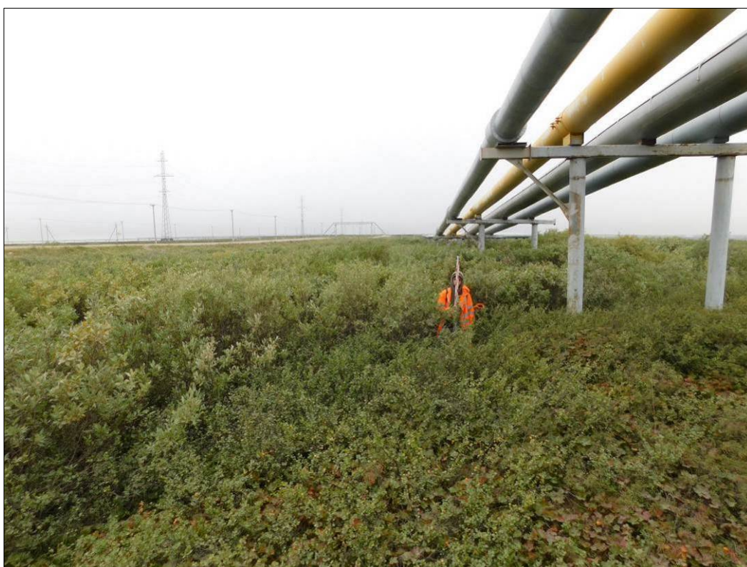
Рис. 39 – Фото. НАО, Заполярный район. Западно-Хоседаюское месторождение. ТФ № 17. Вид на заболоченный лог на участке обследования трассы наземного трубопровода. Снято с северо-востока
