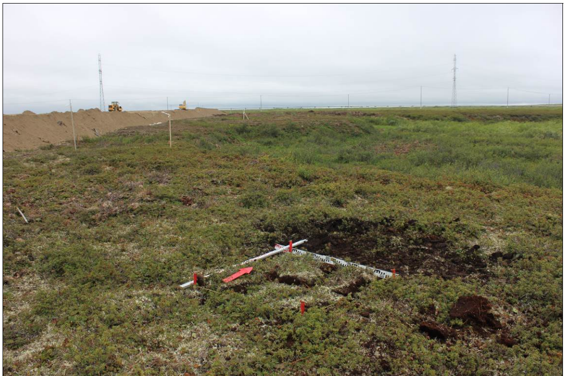
Рис. 79 – Фото. НАО, Заполярный район. Западно-Хоседаюское месторождение. Стратиграфический разрез № 2 (шурф № 2). Рекультивация. Снято с юго-востока
