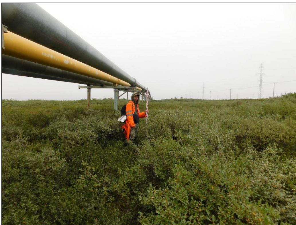
Рис. 42 – Фото. НАО, Заполярный район. Западно-Хоседаюское месторождение. ТФ № 20. Вид на подболоченную, заросшую кустарником низину на участке обследования трассы наземного трубопровода. Снято с юго-запада
