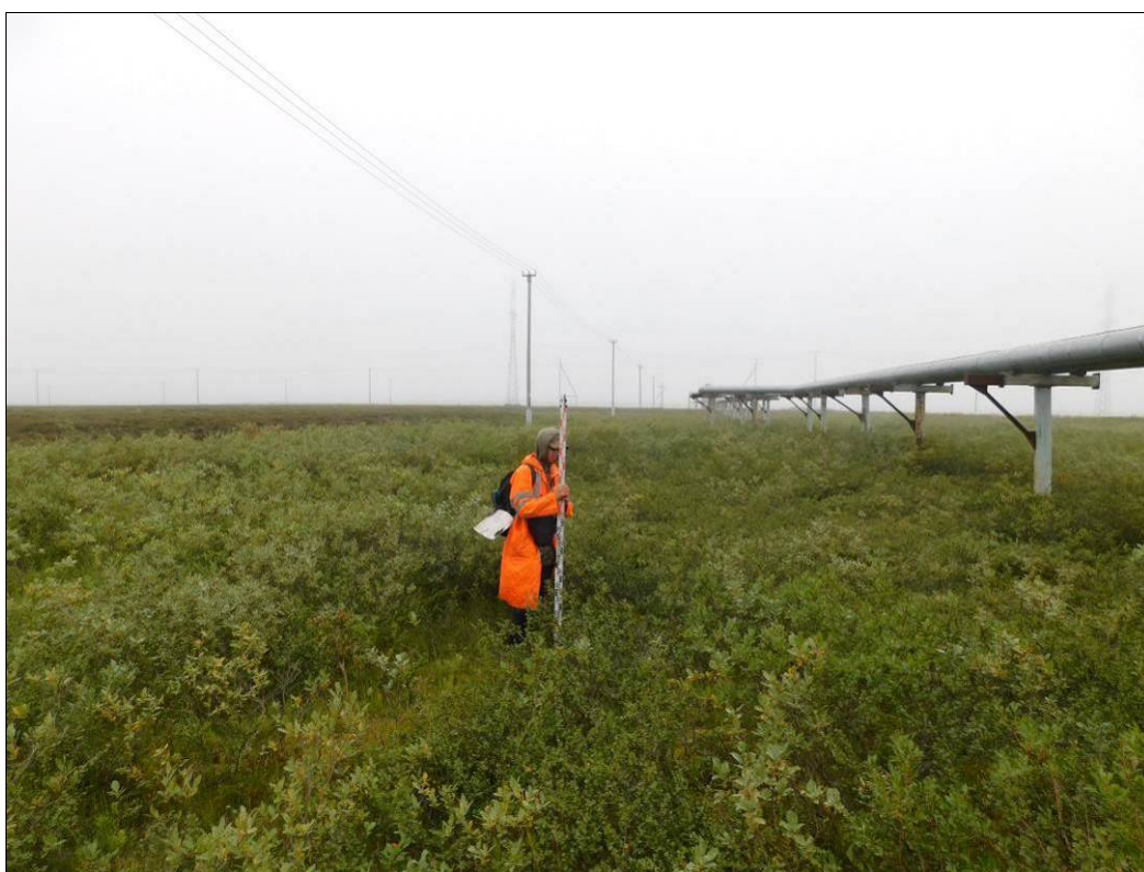
Рис. 69 – Фото. НАО, Заполярный район. Западно-Хоседаюское месторождение. ТФ № 34. Вид на участок обследования трассы наземного трубопровода от кустовой площадки № 8-бис. Снято с юго-востока
