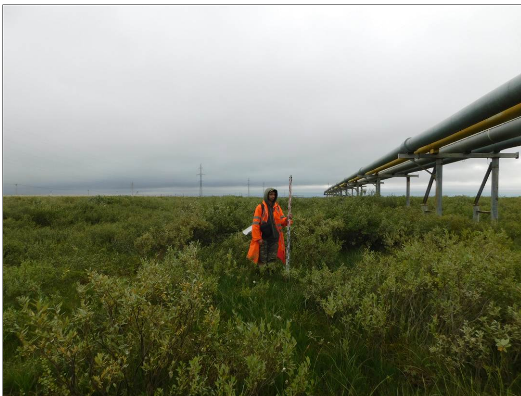
Рис. 34 – Фото. НАО, Заполярный район. Западно-Хоседаюское месторождение. ТФ № 12. Вид на участок прокладки наземного трубопровода. Снято с северо-востока
