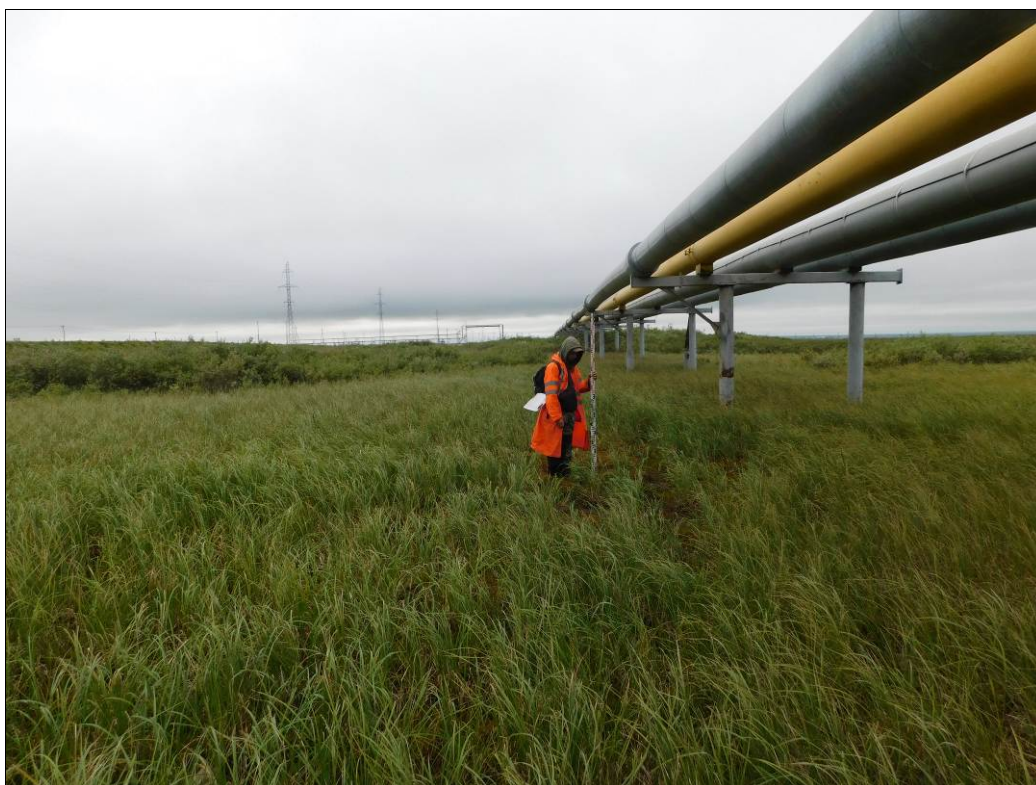
Рис. 35 – Фото. НАО, Заполярный район. Западно-Хоседаюское месторождение. ТФ № 13. Вид на заболоченную тундру на участке прокладки наземного трубопровода. Снято с северо-востока
