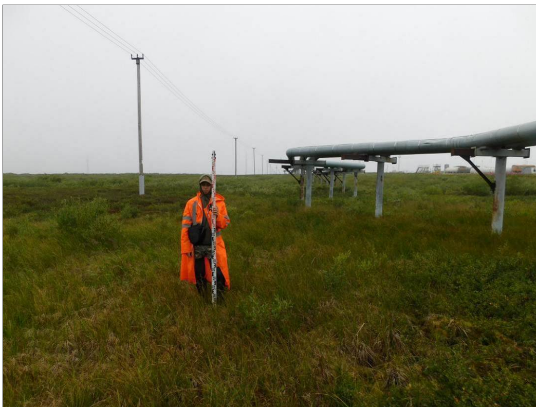
Рис. 68 – Фото. НАО, Заполярный район. Западно-Хоседаюское месторождение. ТФ № 33. Вид на участок обследования трассы наземного трубопровода от кустовой площадки № 8-бис. Снято с юго-востока
