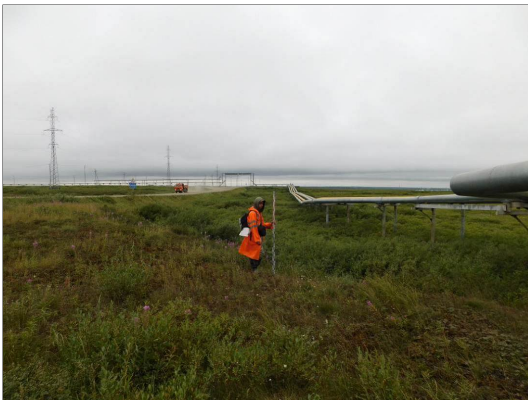
Рис. 36 – Фото. НАО, Заполярный район. Западно-Хоседаюское месторождение. ТФ № 14. Вид на край заболоченного озера на участке обследования трассы наземного трубопровода. Снято с северо-востока
