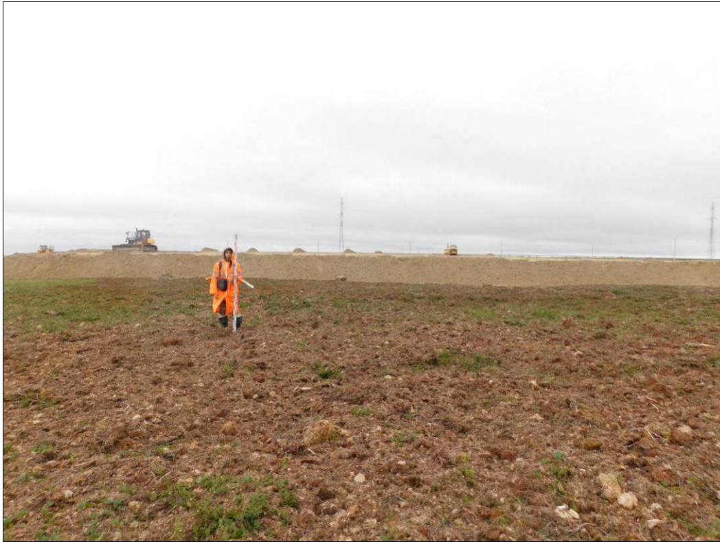
Рис. 18 – Фото. НАО, Заполярный район. Западно-Хоседаюское месторождение. ТФ № 4. Вид на отсыпку кустовой площадки № 17. Снято с юго-востока
