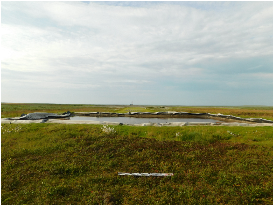
Рис. 21 – Фото. НАО, Заполярный район. Пюсейское месторождение, скважина № 24-р. Точка фотофиксации № 6. Вид на амбар для нефти и площадку скважины. Снято с северо-востока
