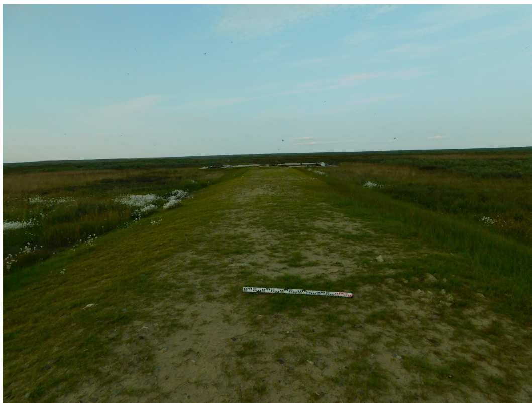
Рис. 17 – Фото. НАО, Заполярный район. Пюсейское месторождение, скважина № 24-р. Точка фотофиксации № 5. Вид на насыпь к амбару для нефти. Снято с юго-запада
