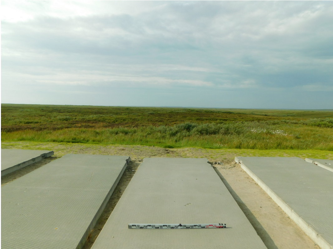
Рис. 8 – Фото. НАО, Заполярный район. Пюсейское месторождение, скважина № 24-р. Точка фотофиксации № 1. Вид на край вертолетной площадки и прилегающую территорию. Снято с северо- востока
