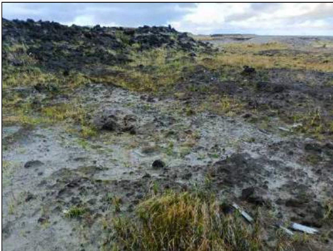
Рисунок 69. «Корректировка технического проекта ш.12393.09П «Сухоройный карьер песка на нефтяном месторождении им. Р. Требса». ТФ 31. Участки с переотложенным грунтом задерновываются кустиками травы. Вид с ЮВ.
