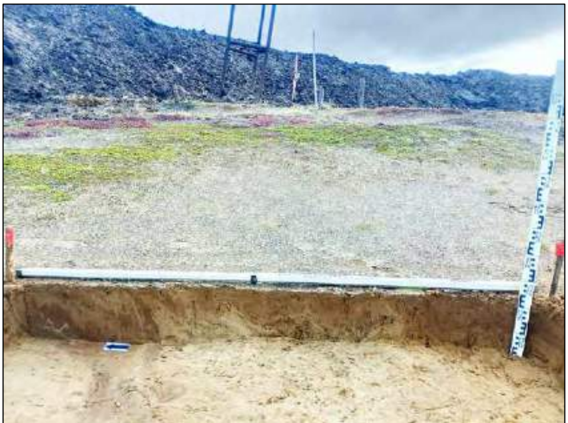
Рисунок 58. «Корректировка технического проекта ш.12393.09П «Сухоройный карьер песка на нефтяном месторождении им. Р. Требса». Шурф №7. Стратиграфический профиль восточной стенки. Вид с 3.
