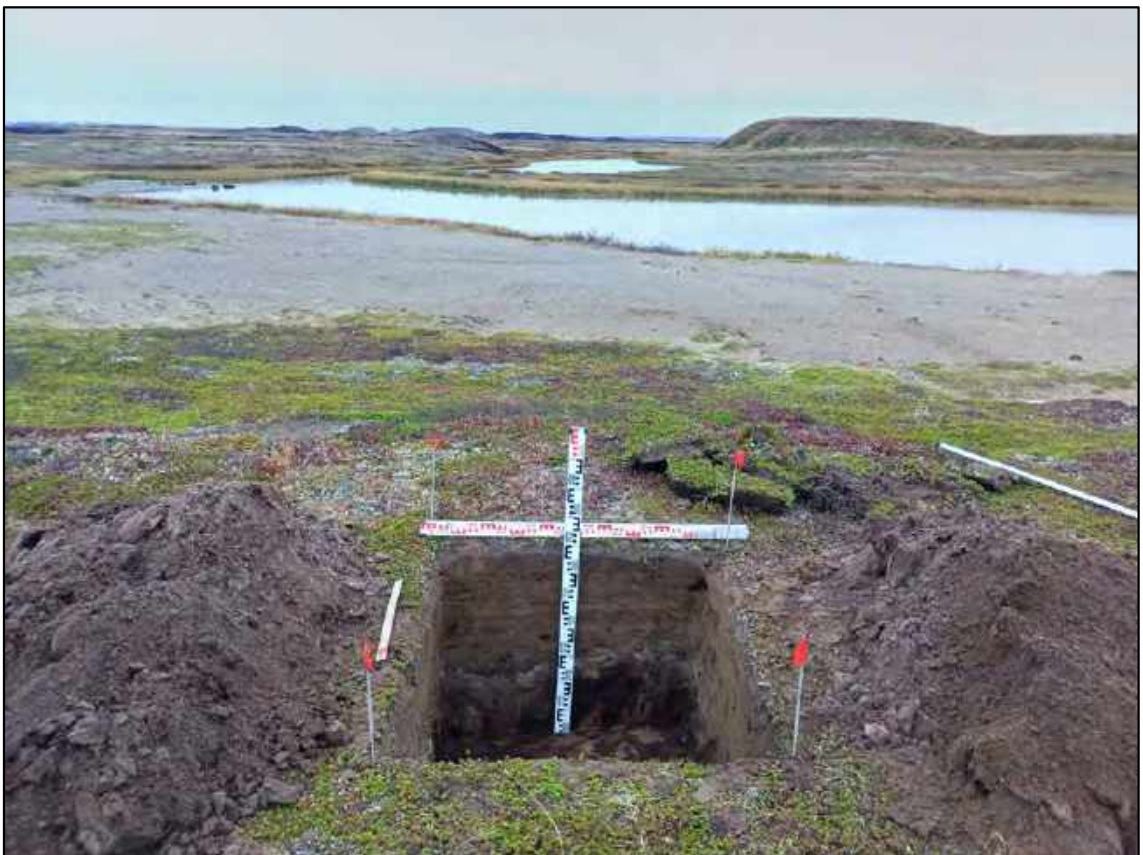
Рисунок 306. «Корректировка технического проекта ш.12393.09П «Сухоройный карьер песка на нефтяном месторождении им. Р. Трбса». Местонахождение Ярдото 6. Шурф Р1-ЯР6-23. Общий вид после выборки. Вид с С.
