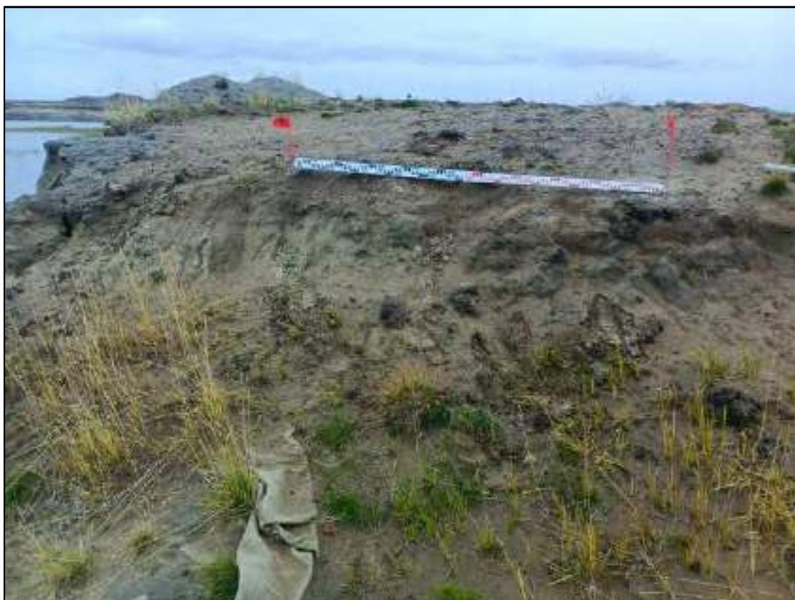
Рисунок 76. «Корректировка технического проекта ш.12393.09П «Сухоройный карьер песка на нефтяном месторождении им. Р. Требса». Зачистка №9. Место закладки. Вид с С.
