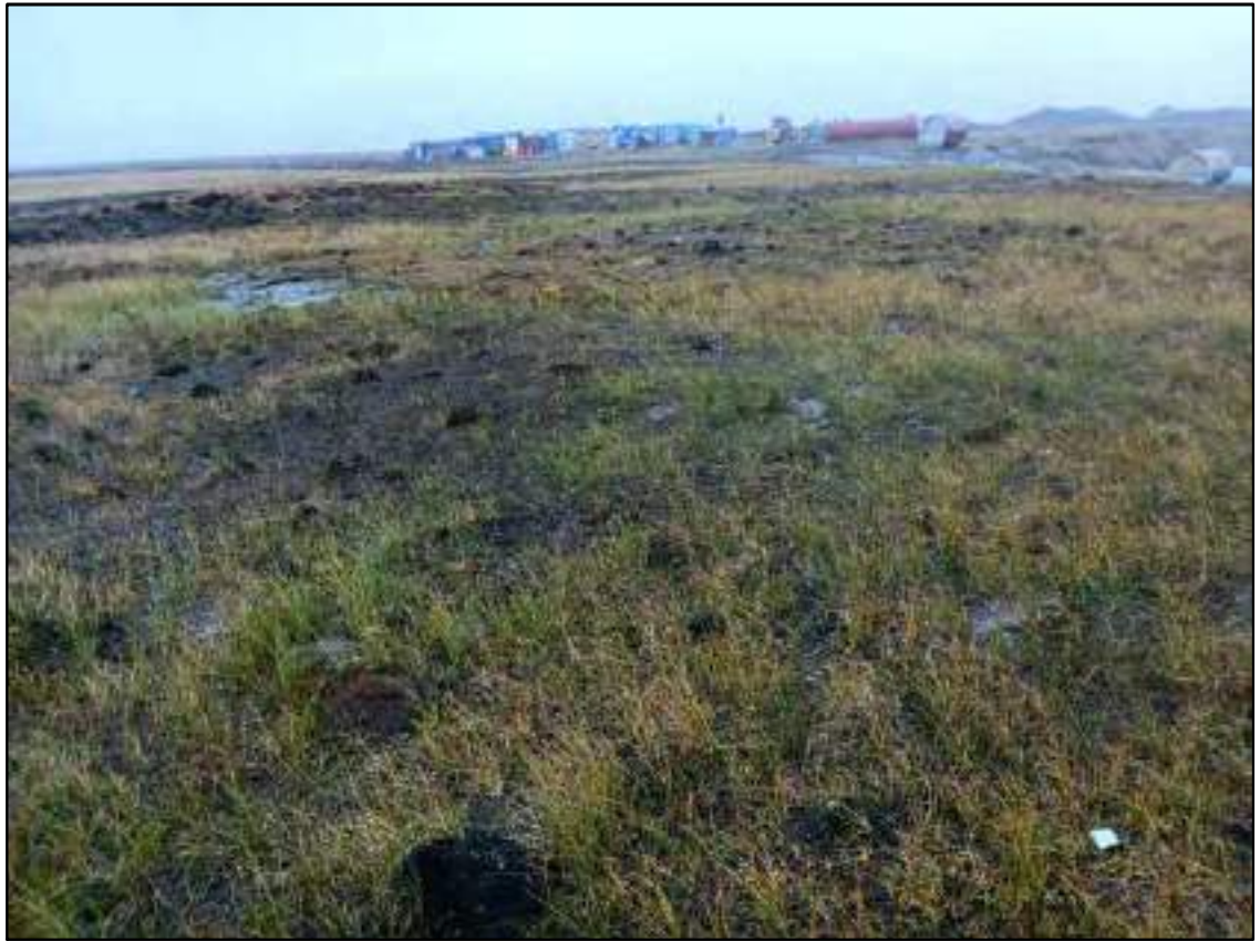
Рисунок 37. «Корректировка технического проекта ш.12393.09П «Сухоройный карьер песка на нефтяном месторождении им. Р. Трбса». ТФ 14. Вахтовый городок. Вид с С.
