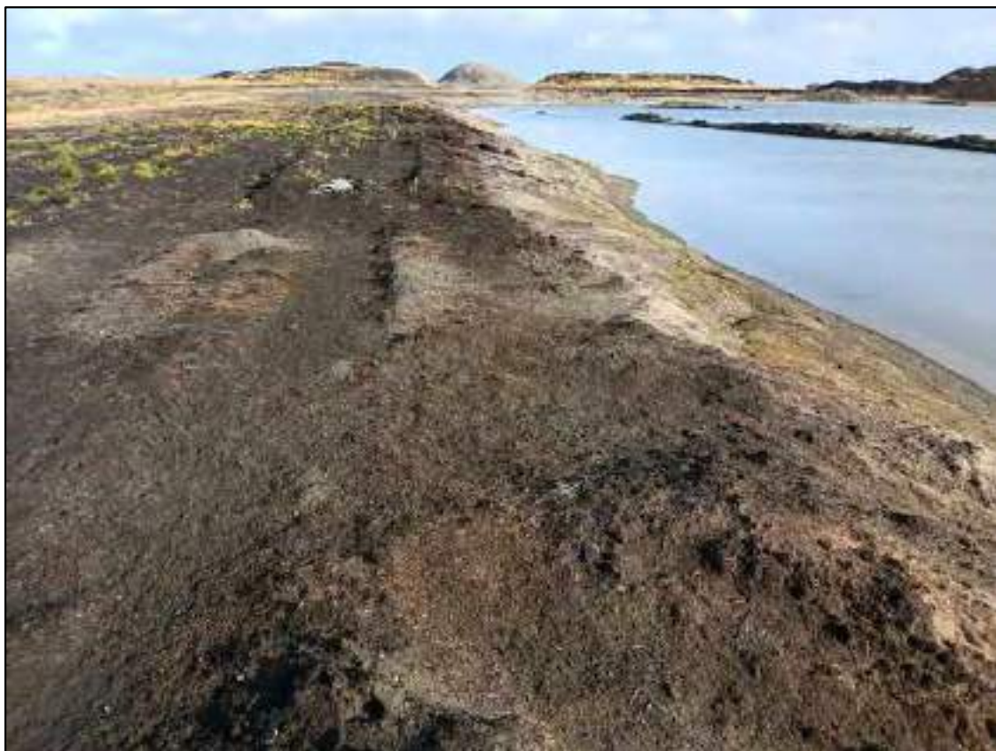
Рисунок 82. «Корректировка технического проекта ш.12393.09П «Сухоройный карьер песка на нефтяном месторождении им. Р. Трбса». ТФ 38. Северо-западный край карьера. Вид с ЮЮЗ.
