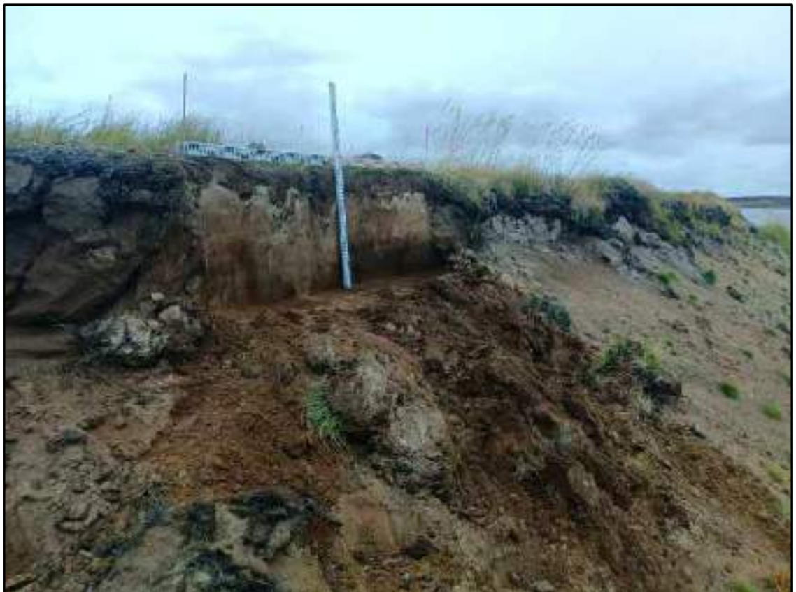
Рисунок 72. «Корректировка технического проекта ш.12393.09П «Сухоройный карьер песка на нефтяном месторождении им. Р. Трбса». Зачистка №8. Общий вид после выборки. Вид с ЮВ.
