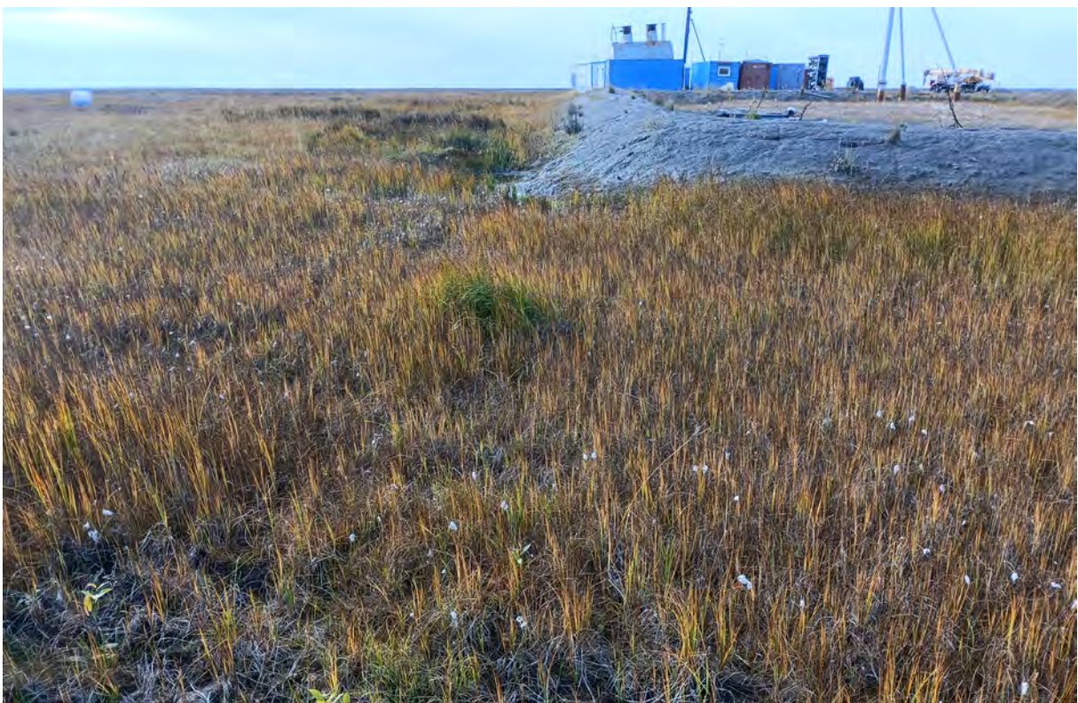
Рис. 22. «Автомобильная дорога АД24 на нефтяном месторождении им. Р.Требса». ТФ 16. Вид с В. Ландшафт около производственной площадки. Фото.
