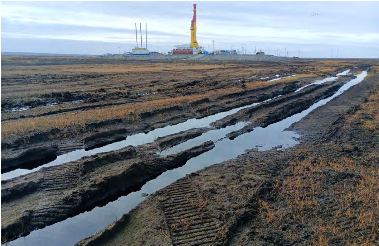
Рис. 125. «Автомобильная дорога АД24 на нефтяном месторождении им. Р.Требса». ТФ 111. Вид с С. Многочисленные колеи, заполненные водой. Наглядно демонстрируют степень обводненности тундры. На втором плане буровая. Фото.
