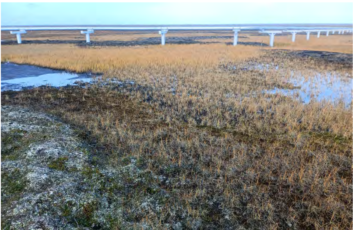
Рис. 128. «Автомобильная дорога АД24 на нефтяном месторождении им. Р.Требса». ТФ 114. Вид с В. Трубопровод в болоте. Фото.
