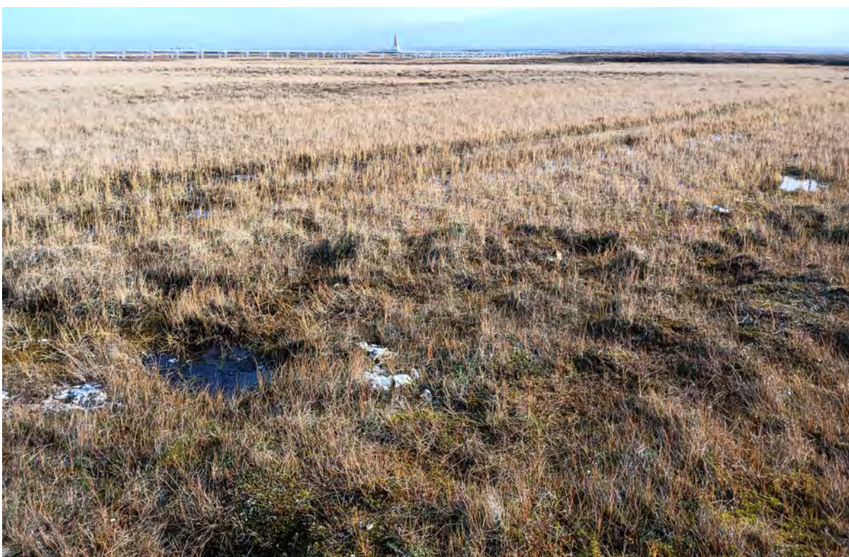
Рис. 78. «Автомобильная дорога АД24 на нефтяном месторождении им. Р.Требса». ТФ 68. Вид с З. Колея вездехода, пересекающая кочковатую тундру. Вдали трубопровод и буровая. Фото.
