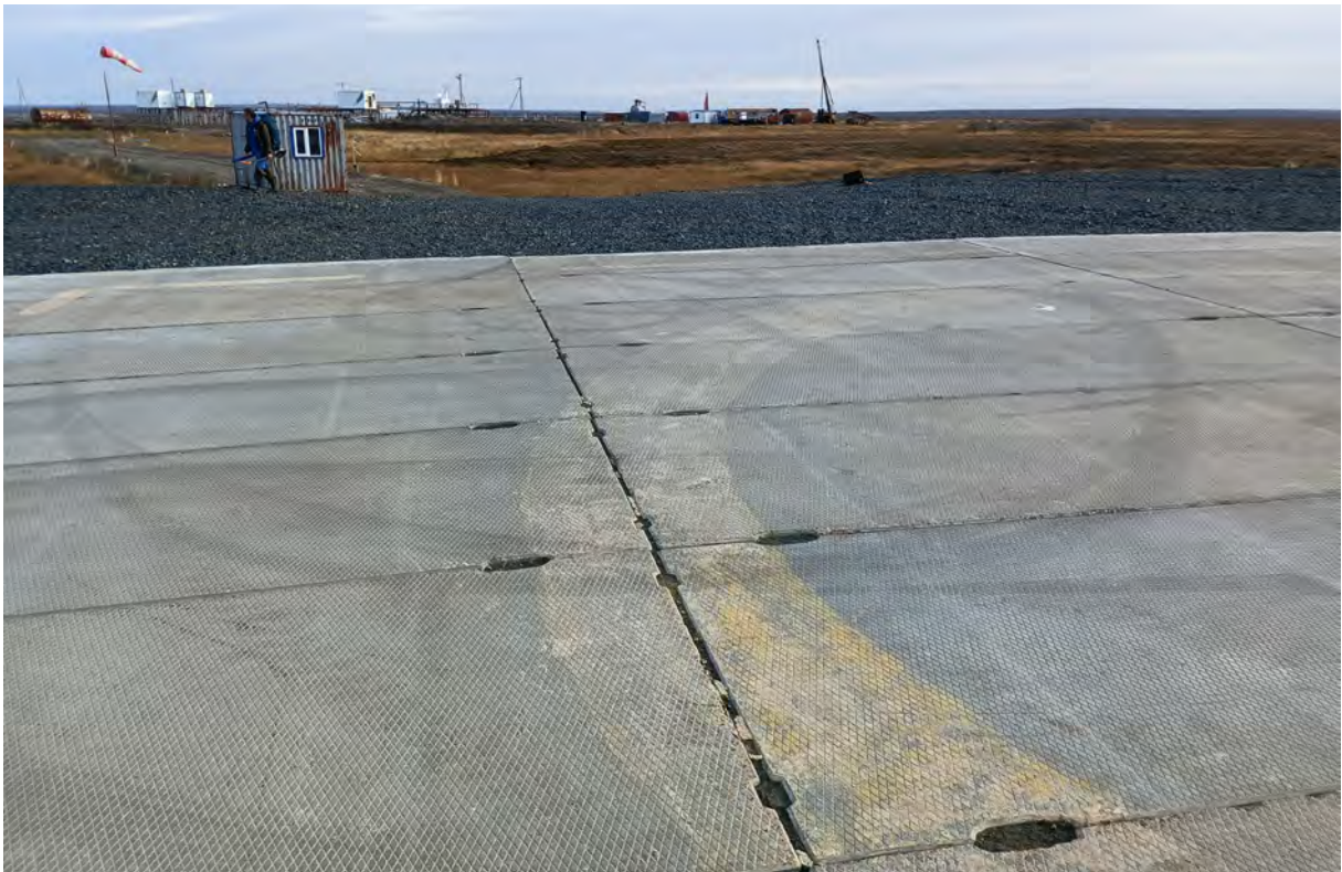
Рис. 7. «Автомобильная дорога АД24 на нефтяном месторождении им. Р.Требса». ТФ 1. Вид с С. Производственные площадки, отсыпанные щебнем и выложенные бетонными плитами. Фото.
