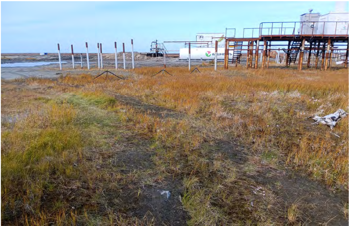
Рис. 19. «Автомобильная дорога АД24 на нефтяном месторождении им. Р.Требса». ТФ 13. Вид с Ю. Производственная площадка. Фото.
