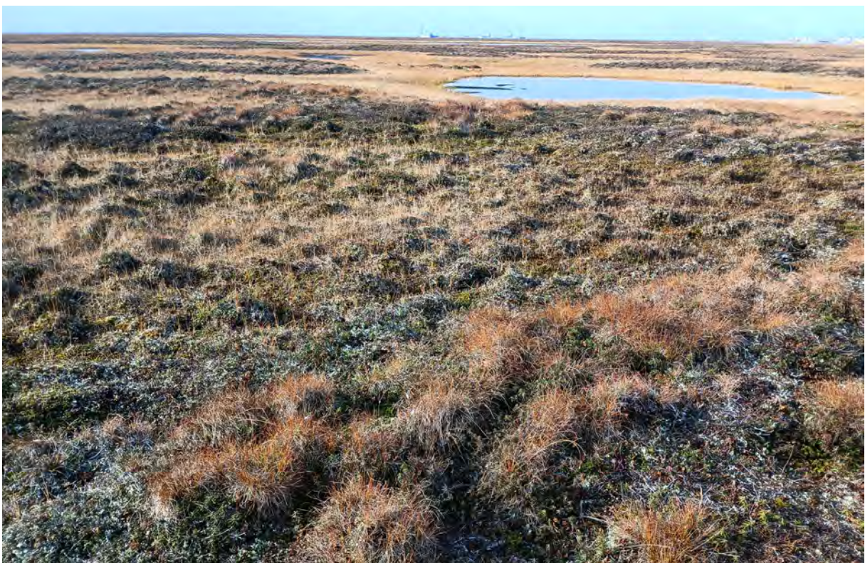
Рис. 68. «Автомобильная дорога АД24 на нефтяном месторождении им. Р.Требса». ТФ 58. Вид с В. Кочковатая тундра с участками заболачивания. Вдали производственные площадки. Фото.
