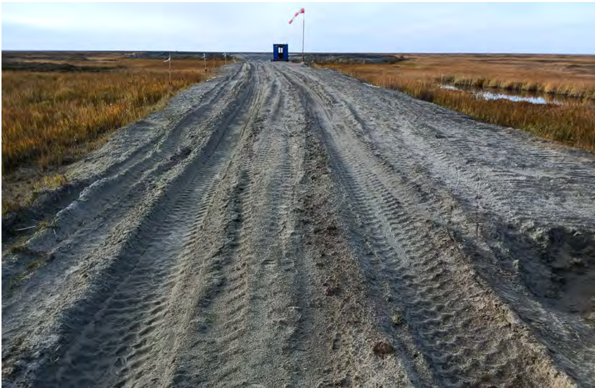
Рис. 9. «Автомобильная дорога АД24 на нефтяном месторождении им. Р.Требса». ТФ 3. Вид с ЮВ. Дорога, отсыпанная песком, на площадку из щебня, выложенную бетонными плитами. Фото.
