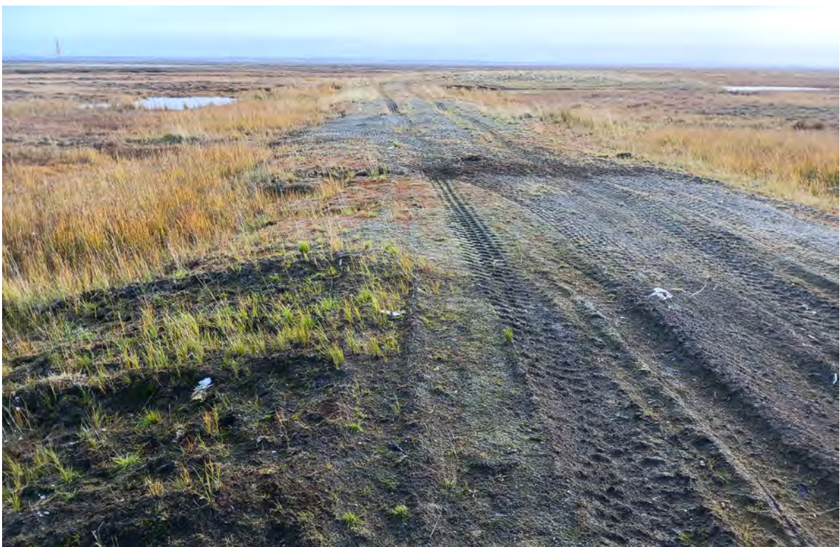
Рис. 18. «Автомобильная дорога АД24 на нефтяном месторождении им. Р.Требса». ТФ 12. Вид с С. Дорога между двумя производственными площадками. Фото.
