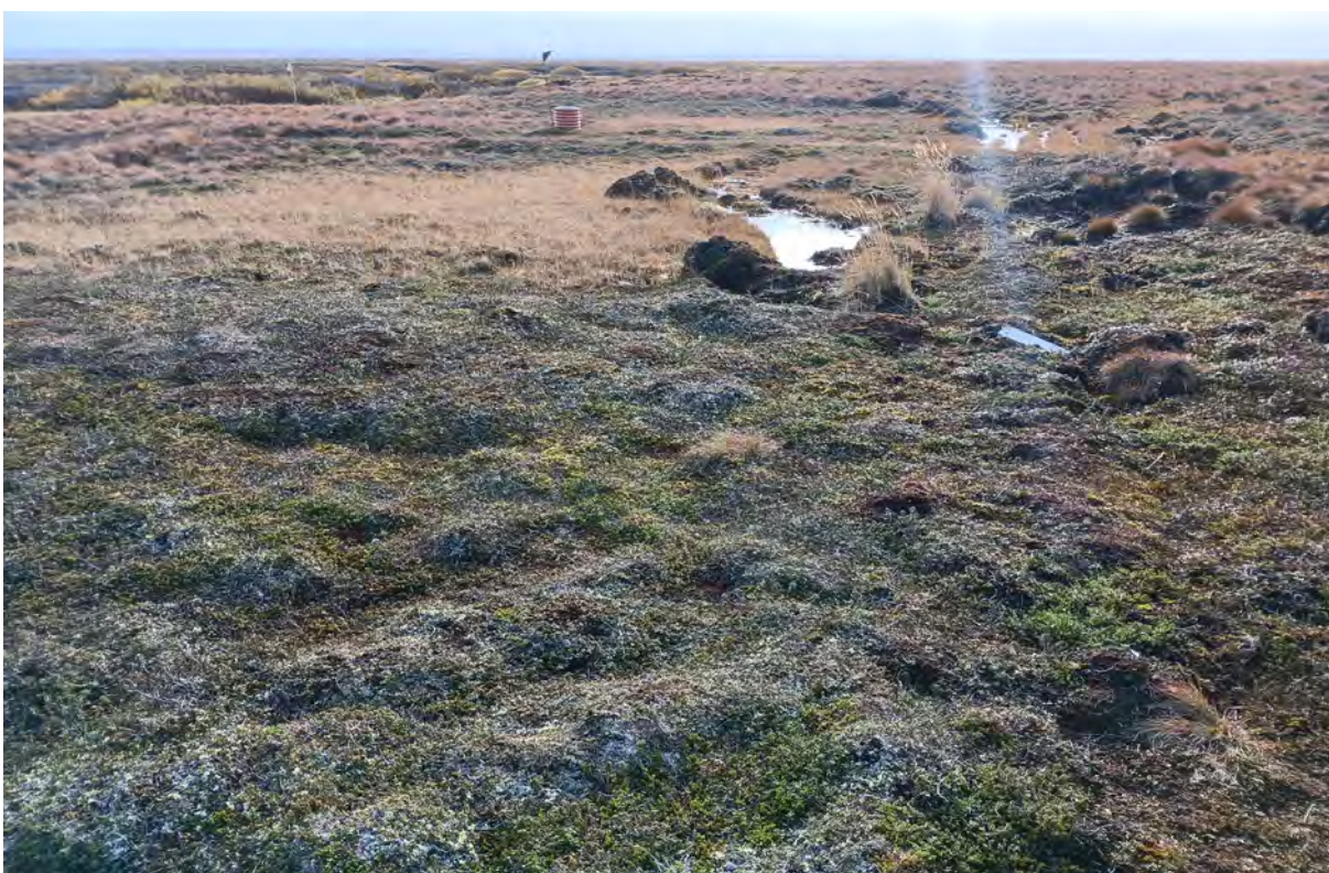
Рис. 24. «Автомобильная дорога АД24 на нефтяном месторождении им. Р.Требса». ТФ 18. Вид с Ю. Ландшафтная ситуация. Фото.
