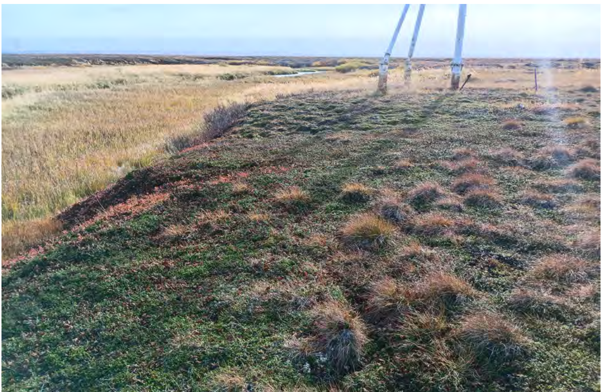
Рис. 30. «Автомобильная дорога АД24 на нефтяном месторождении им. Р.Требса». ТФ 20. Вид с С. Берег и русло ручья. Фото.
