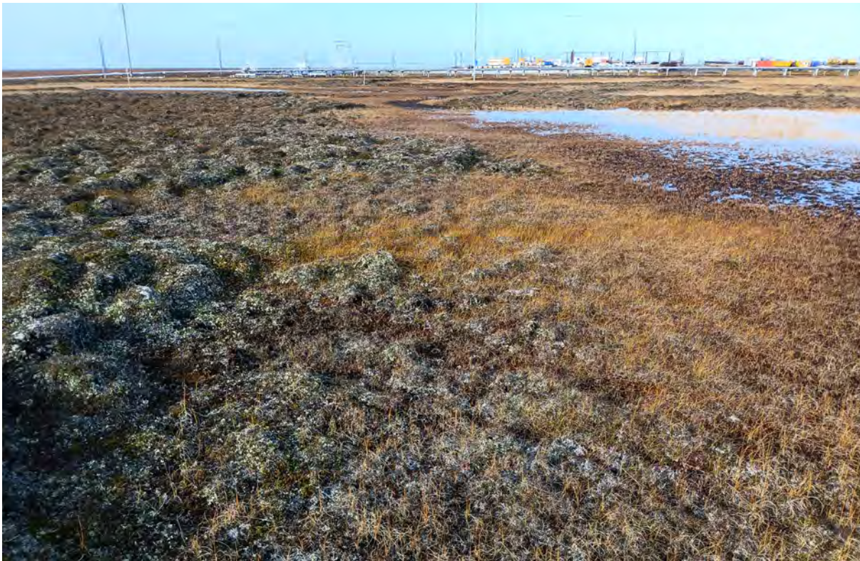
Рис. 41. «Автомобильная дорога АД24 на нефтяном месторождении им. Р.Требса». ТФ 31. Вид с Ю. Репер в типичной для северной тундры ландшафтной ситуации. Фото.
