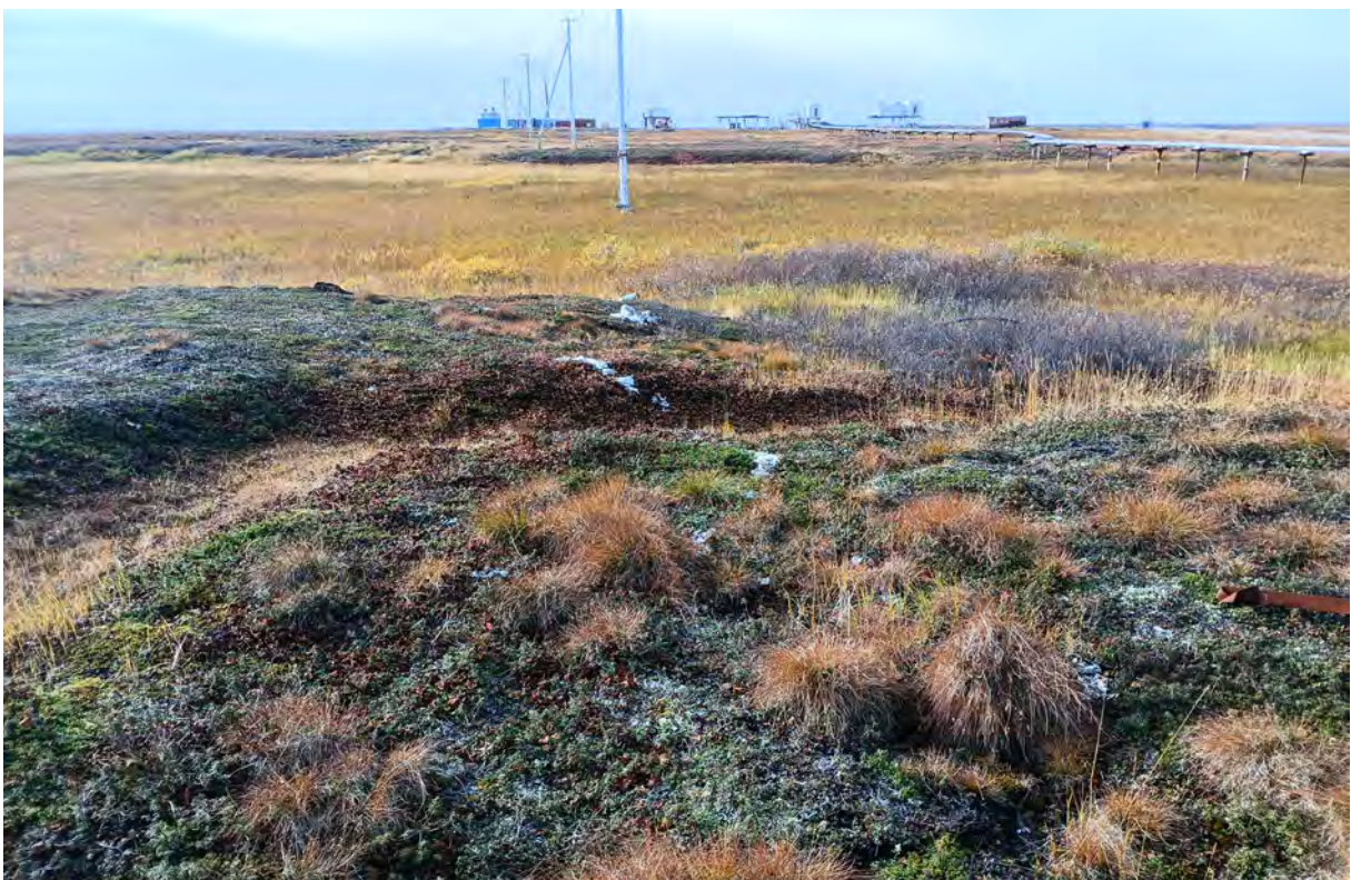
Рис. 32. «Автомобильная дорога АД24 на нефтяном месторождении им. Р.Требса». ТФ 22. Вид с ВСВ. Трубопровод и ЛЭП. Фото.
