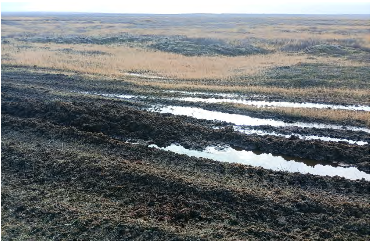
Рис. 126. «Автомобильная дорога АД24 на нефтяном месторождении им. Р.Требса». ТФ 112. Вид с З. Вездеходные колеи, заполненные водой. Фото.
