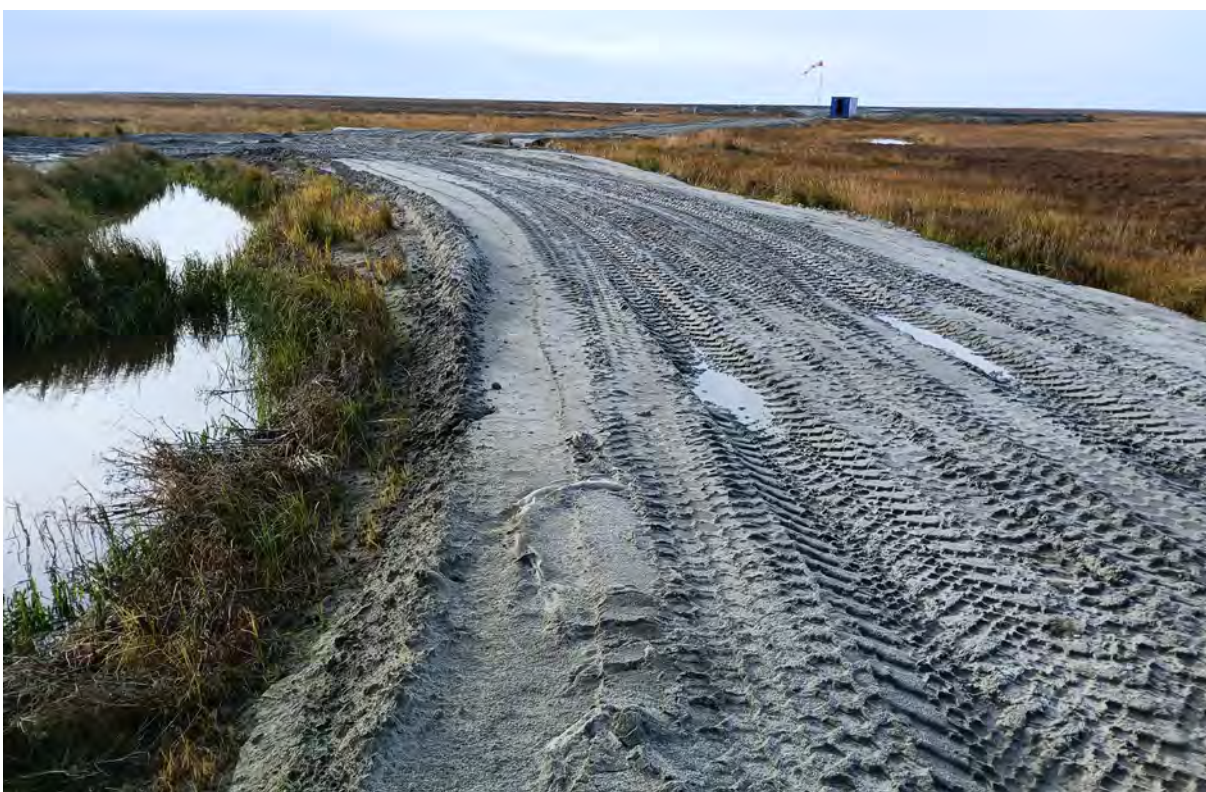
Рис. 10. «Автомобильная дорога АД24 на нефтяном месторождении им. Р.Требса». ТФ 4. Вид с В. Песчаная дорога, проложенная в болоте. Фото.
