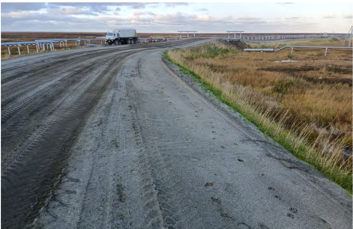
Рис. 122. «Обустройство кустовой площадки К-66 на нефтяном месторождении им. Р. Трбса». ТФ 98. Вид с ЮЗ. Автодорога и трубопровод вдоль нее. Фото.
