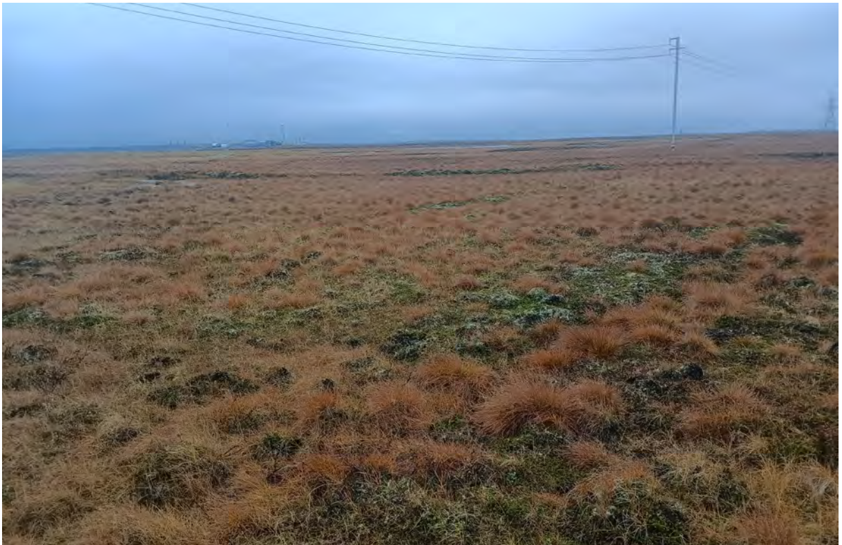
Рис. 125. «Обустройство кустовой площадки К-66 на нефтяном месторождении им. Р. Трещса». ТФ 101. Вид с СВ. ЛЭП в типичном для тундры ландшафте. Фото.
