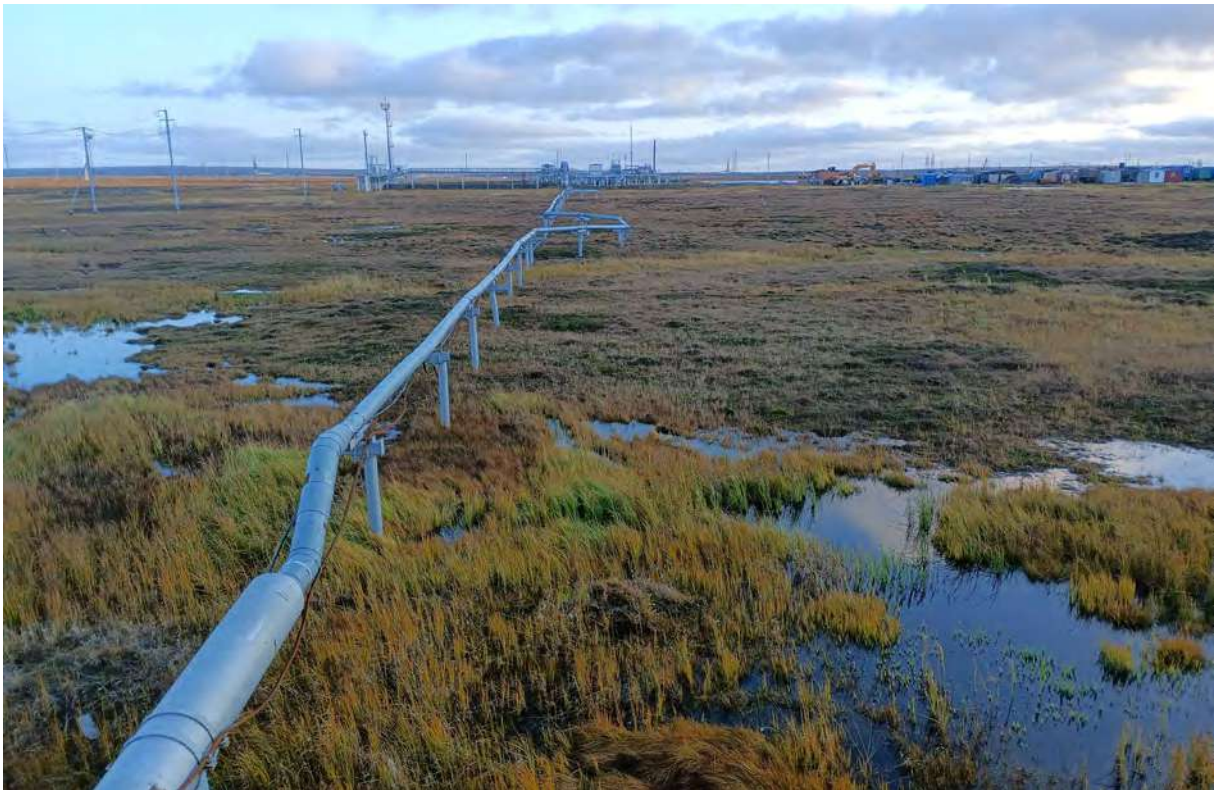
Рис. 121. «Обустройство кустовой площадки К-66 на нефтяном месторождении им. Р. Трбса». ТФ 97. Вид с ССЗ. Трубопровод на участке заболоченной тундры. Фото.
