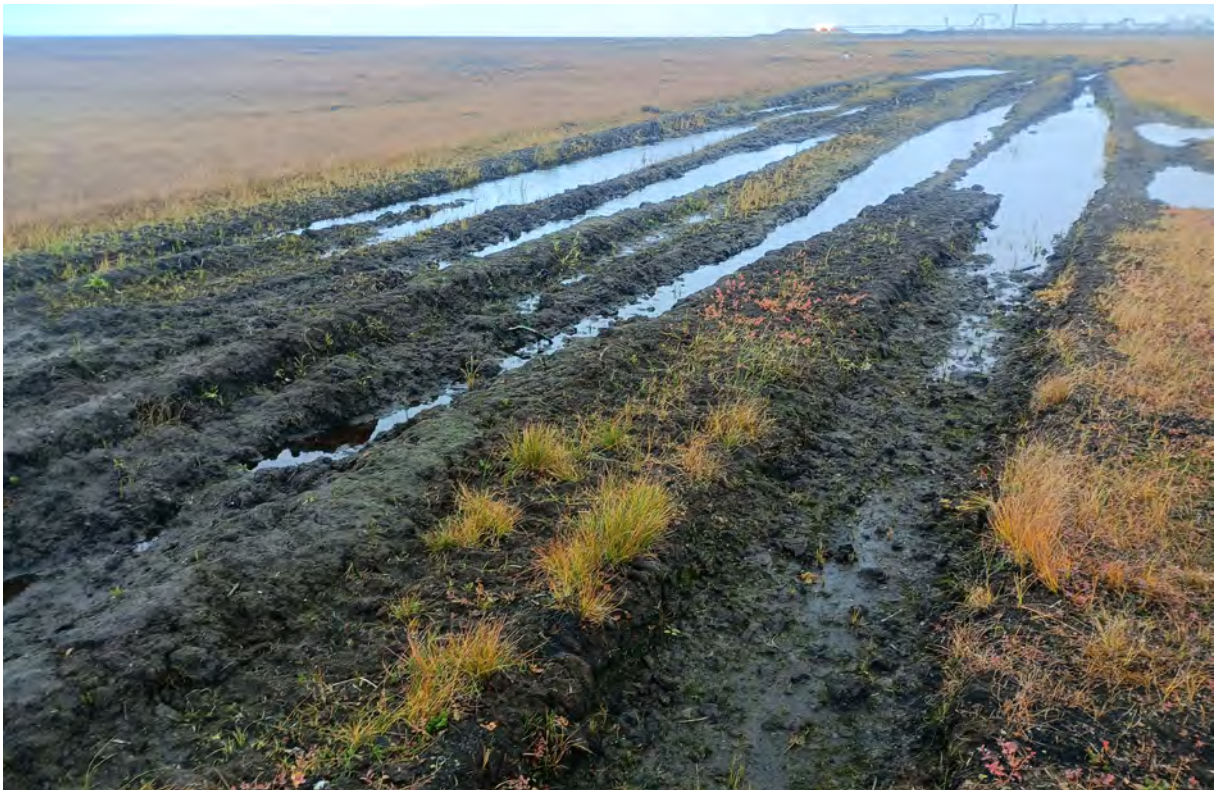
Рис. 127. «Обустройство кустовой площадки К-66 на нефтяном месторождении им. Р. Трбса». ТФ 103. Вид с Ю. Грунтовая дорога с заполненными водой колеями. Фото.
