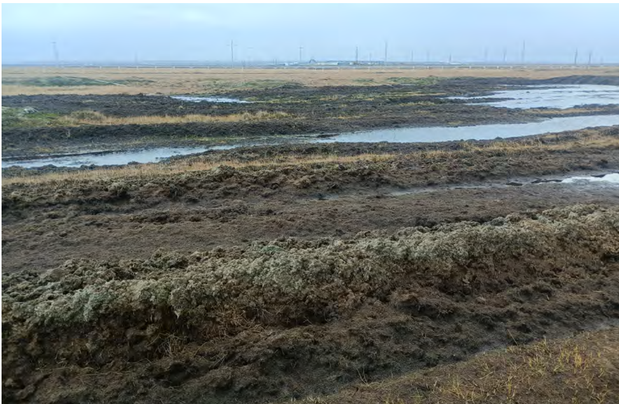
Рис. 129. «Обустройство кустовой площадки К-66 на нефтяном месторождении им. Р. Трбса». ТФ 105. Вид с ЗЮЗ. «Дорога» через заболоченные участки тундры. Фото.
