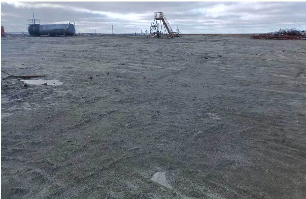
Рис. 38. «Обустройство кустовой площадки К-66 на нефтяном месторождении им. Р. Тресса». ТФ 25. Вид с З. Площадка куста, отсыпанная песком. Фото.
