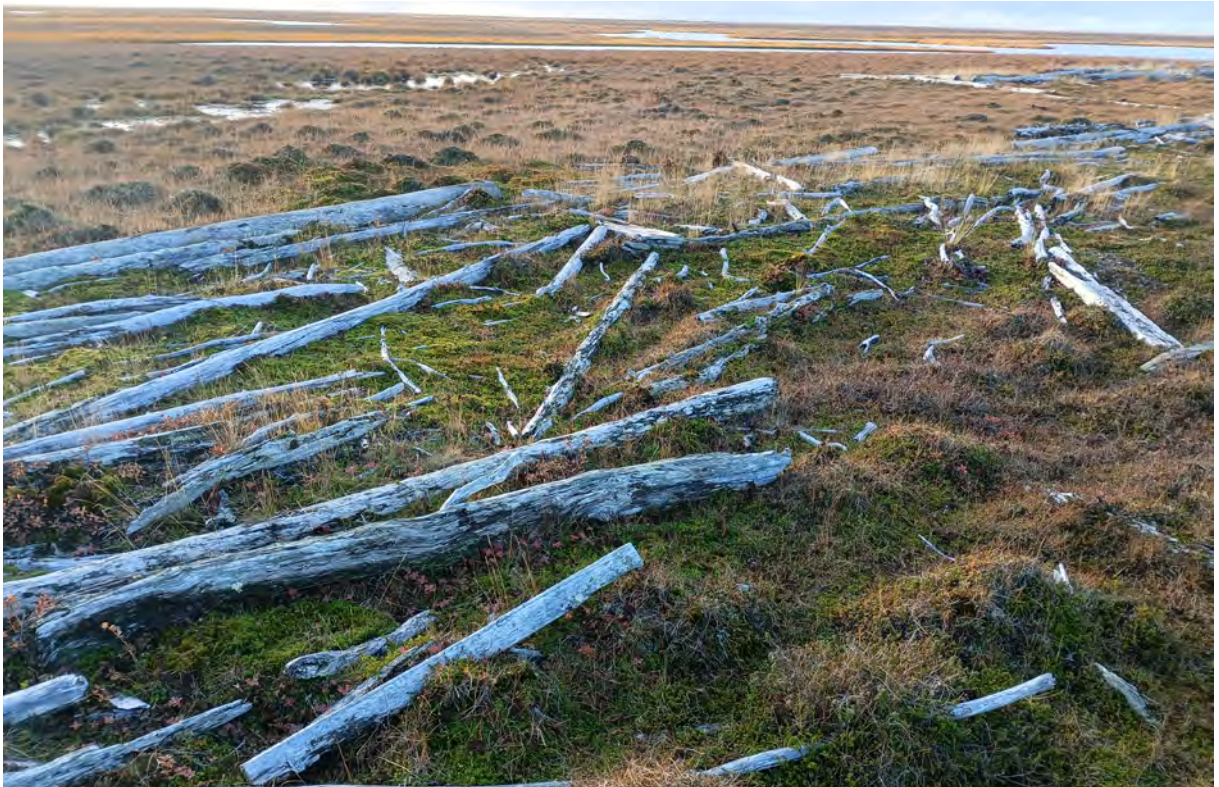
Рис. 109. «Обустройство кустовой площадки К-66 на нефтяном месторождении им. Р. Трбса». ТФ 85. Вид с ВСВ. Остатки деревьев и бревен. Фото.
