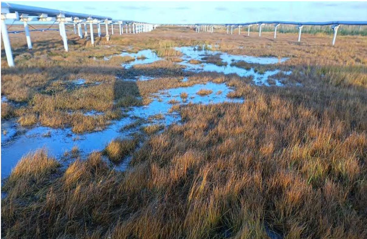
Рис. 119. «Обустройство кустовой площадки К-66 на нефтяном месторождении им. Р. Трбса». ТФ 95. Вид с ЗЮЗ. Заболоченные участки между двумя трубопроводами. Фото.
