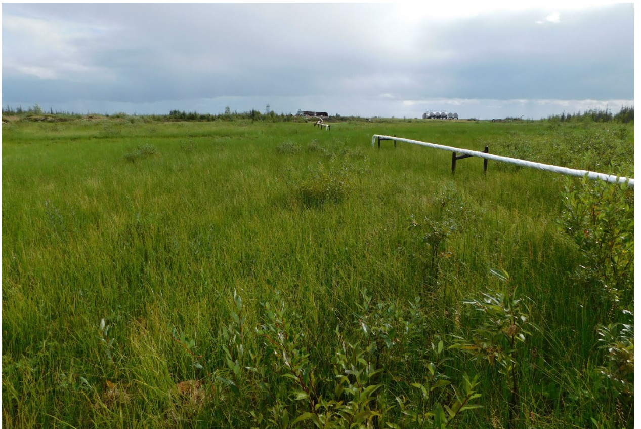
Рис. 36. Фото. НАО, «Обустройство Лыдушорского месторождения». Восточная часть участка. Существующий трубопровод коридора коммуникаций к кусту №1 Вид с севера.
