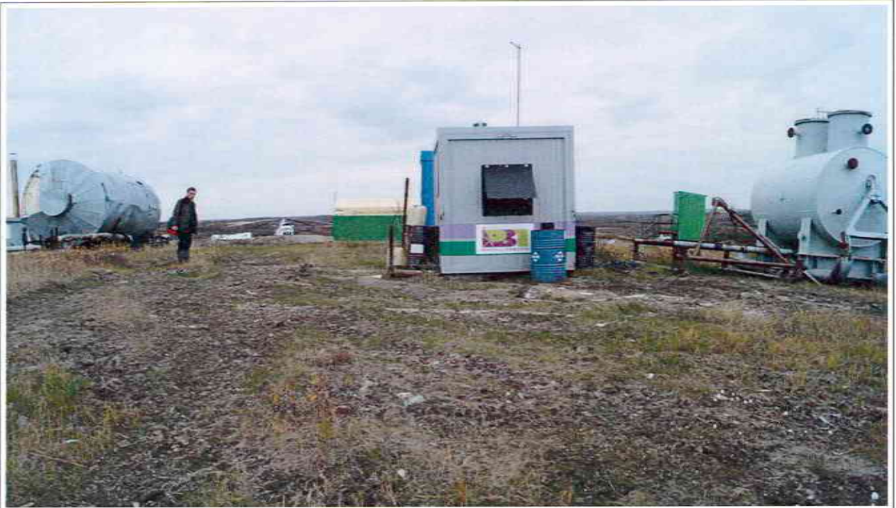
Графическое приложение 16. Фото. НАО. Заполярный район. Вид на балки и сооружения в районе одиночной скважина № 30 объекта «Урернырдское месторождение ЦПХ (блок № 4). Одиночная скважина № 30». Сентябрь 2016 г.
