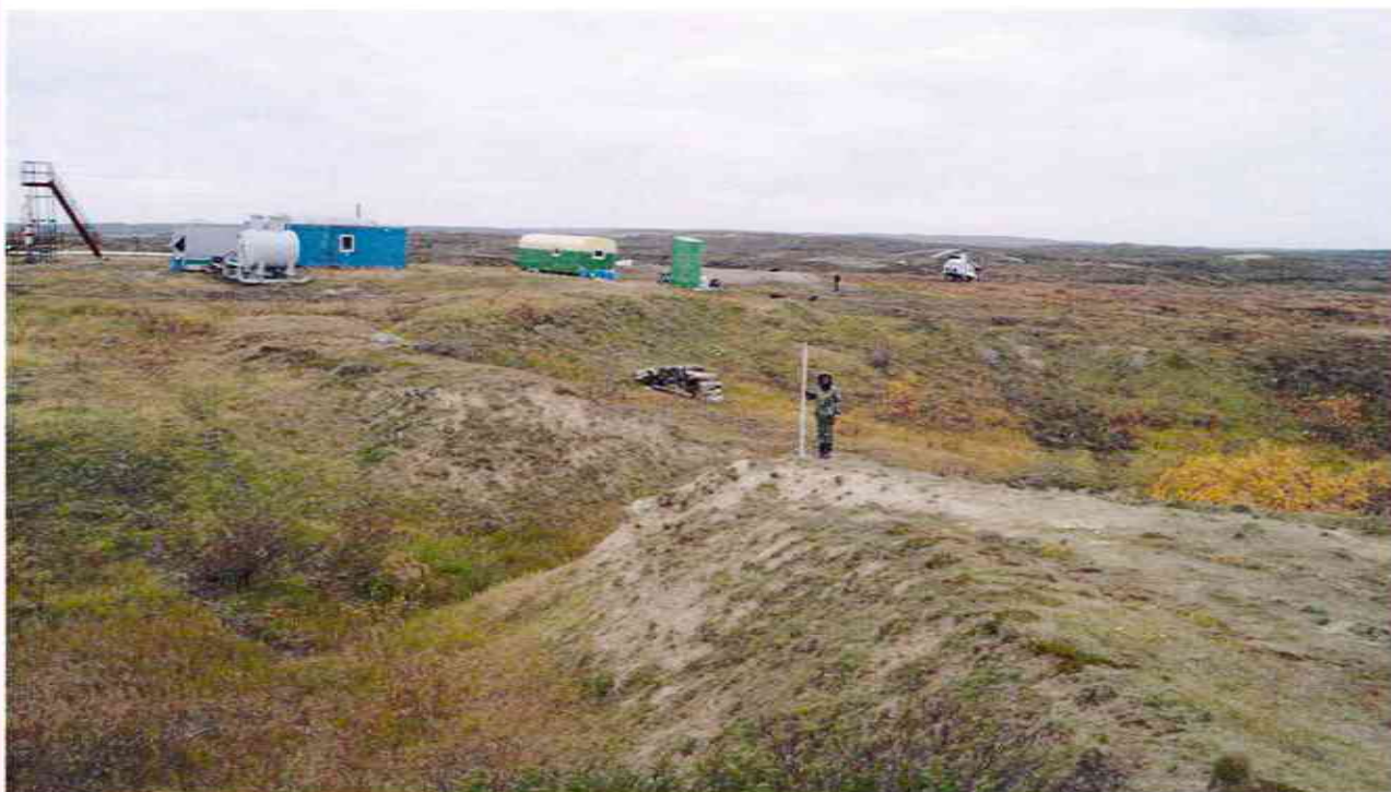
Графическое приложение 9. Фото. НАО. Заполярный район. Западный участок объекта «Урернырдское месторождение ЦПХ (блок № 4). Одиночная скважина № 30». Вид на разрушенную дамбу (сооружение 1970-80-х гг.). Сентябрь 2016 г.
