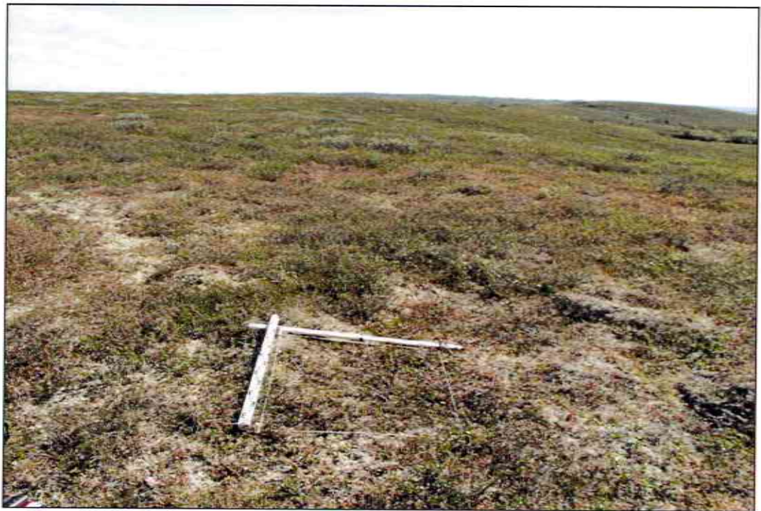
Рис. 31. НАО. Заполярный район. Участок проектируемого газопровода Оксино-Хонгурей-Каменка. Разбивка стратиграфического разреза (шурфа) № 6. Снято с юга. Июль 2016 г.
