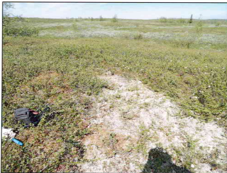
Рис. 43. НАО. Заполярный район. Участок проектируемого газопровода Оксино-Хонгурей-Каменка. Разбивка стратиграфического разреза (шурфа) №10. Снято с востока. Июль 2016 г.
